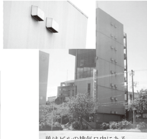
巣はビルの排気口内にある
